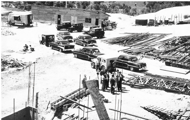
TRIGA Mark-II 원자로 건설 현장(1959. 7. 14.)
