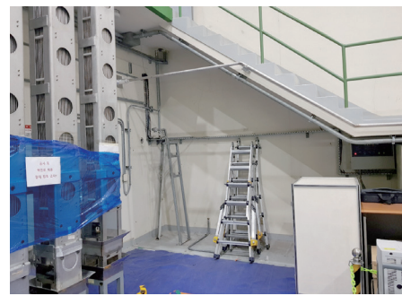
② CO2 설비 철거 후
