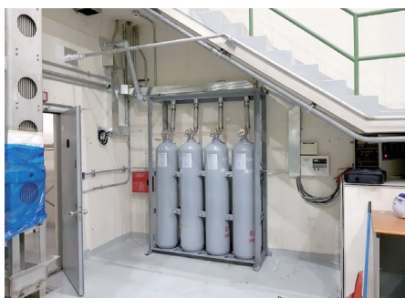
③ 신규설비(Novac-1230) 설치
