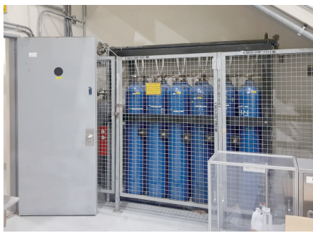
① CO2 설비 철거 전
